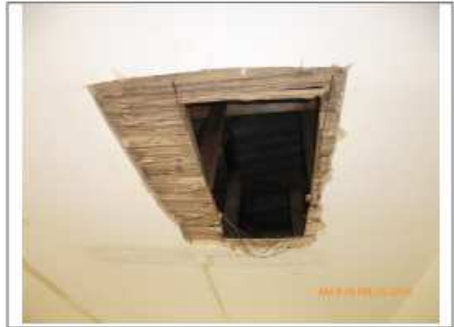
Foto 2: Cielo raso en estera de guadua, apuntalada a la estructura de madera, con mortero de recubrimiento.
