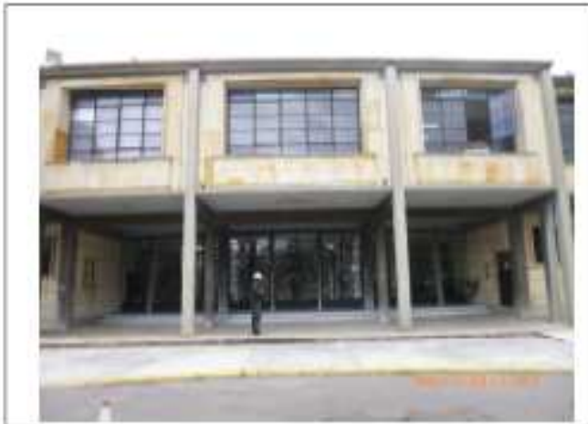
Foto 3: Fachada frontal acceso donde se identifican los dos primeros pisos
