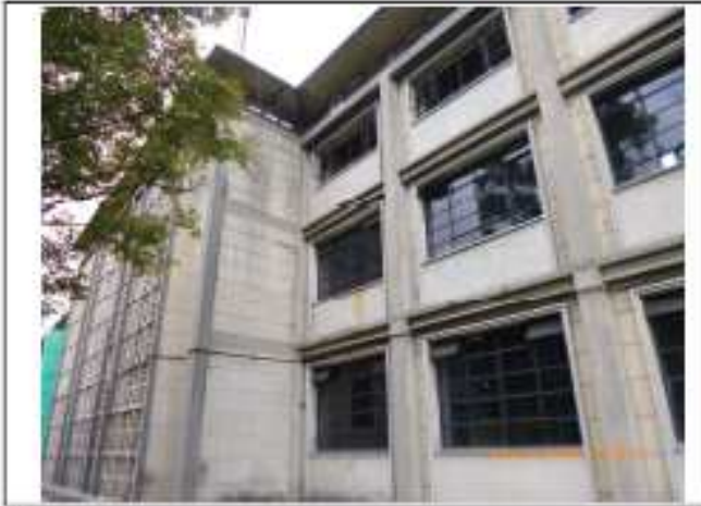
Foto 1: Fachada norte donde se ve la modulación de la estructura y fachada
