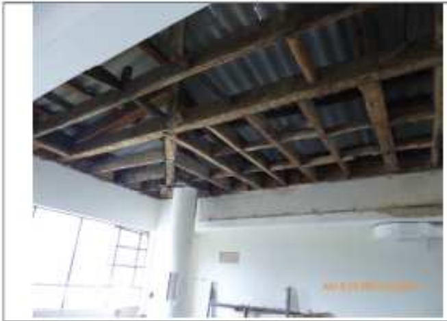
Foto 1: vista de cubierta desde 3 nivel, estructura cubierta en madera y teja eternit- viga de remate en concreto
