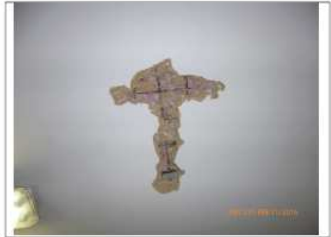
Foto 4: Refuerzo en placas de los niveles 2 y 3.
