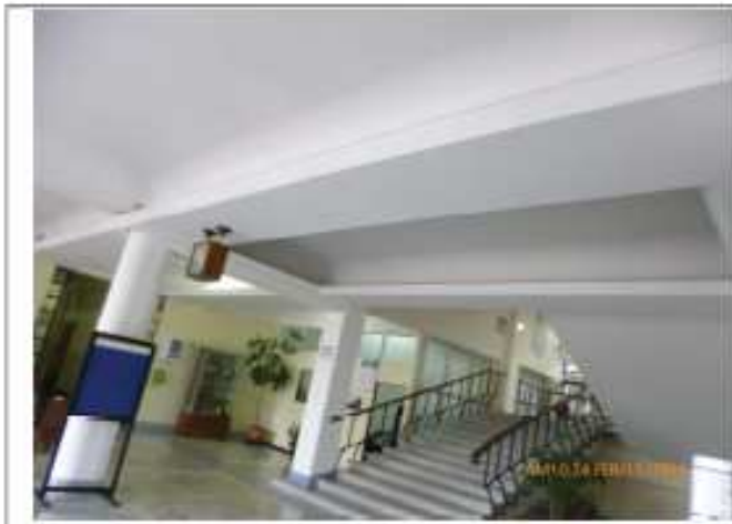
Foto 1: vista sobre hall y punto fijo.
