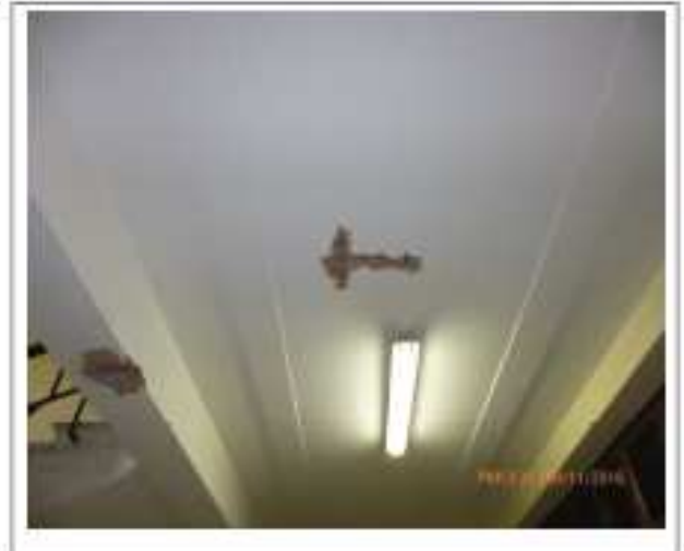
VISTA DE REGATAS DE EXPLORADO EN PLACA 3 PISO REF INFERIOS ESTAS PLACAS SOLO SE INSPECCIONARON POR
