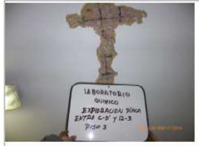
REFUERZO INFERIOR PLACA 3 PISO ENTRE EJES C-D Y 12-13 SEPARACION REFUERZO 10 CM EN N° 3
