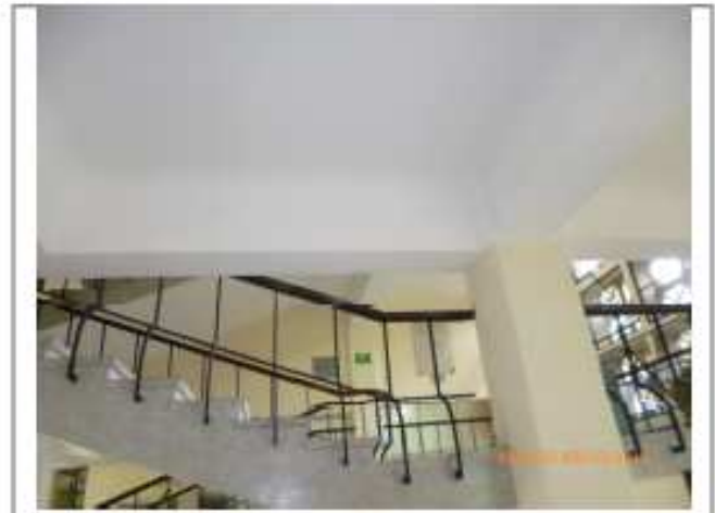
Foto 2: conformacion estructura en zona de punto fijo, amado de la placa.
