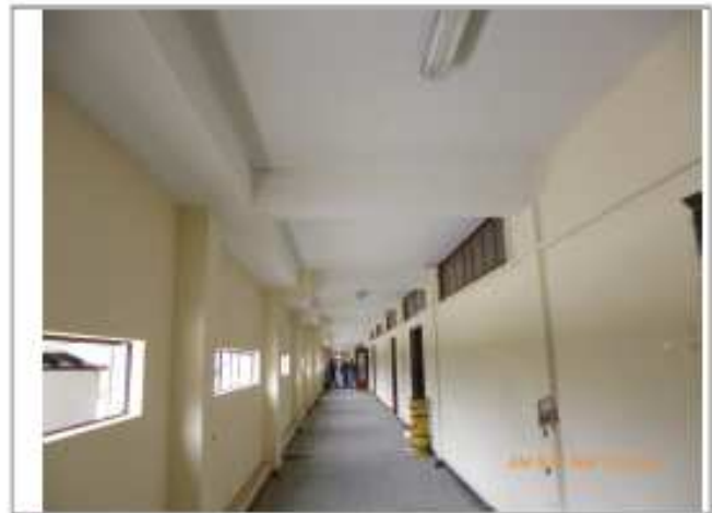
Foto 4 : Proceso de remodelación en 3 piso, conformación de la estructura de cubierta.
