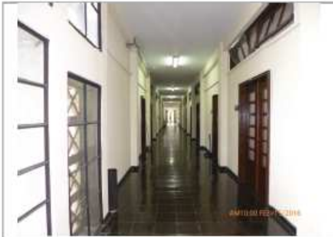
Foto 3 : Corredor interno primer piso don de se observa la conformacion de la estructura
