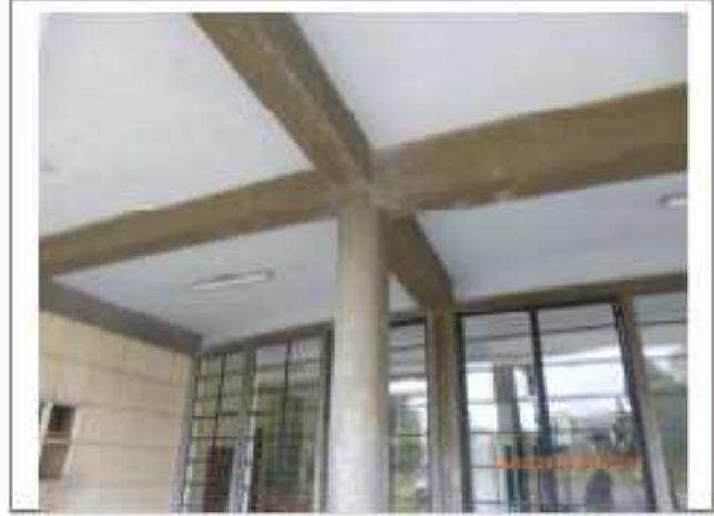
Foto 2: Acceso al edificio donde se identifica el sistema de porticos
