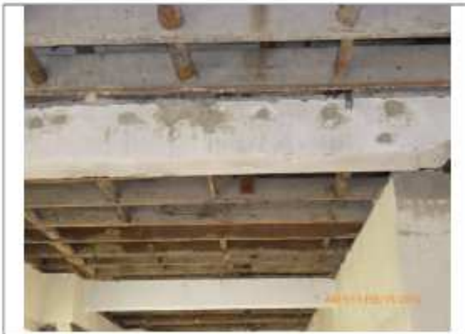
Foto 3 : Disposición de la estructura de madera para cubierta y amarré con la estructura de concreto
