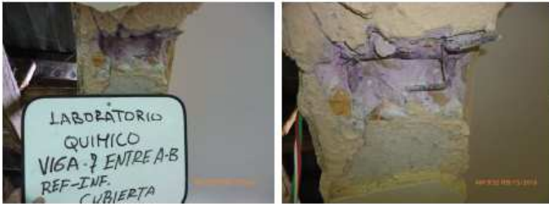
Sección Transversal e Identificación de Refuerzo:
