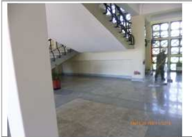
Foto 1: Exploración Columna 12-A Punto fijo, donde se analizaron dos caras
